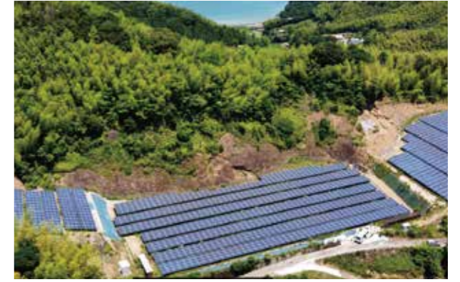
阿波福井太陽光発電所 698.88kW
