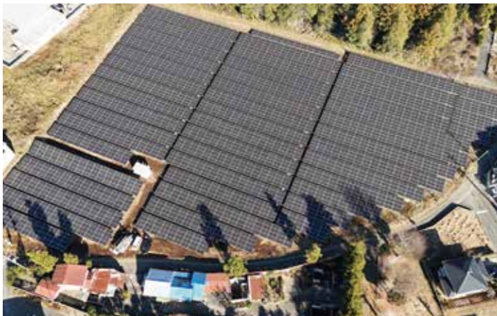
リープтон茨城町小幡発電所 1.59MW
