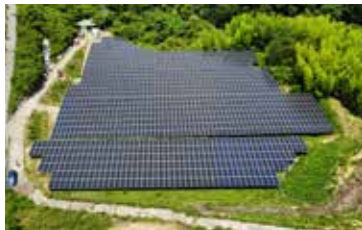
淡路岩屋発電所 1.09MW
