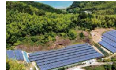
阿波福井太陽光発電所 698.88kW
