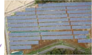
茨城県茨城町太陽光発電所 1MW
