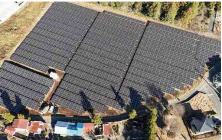
リープトン茨城町小幡発電所 1.59MW
