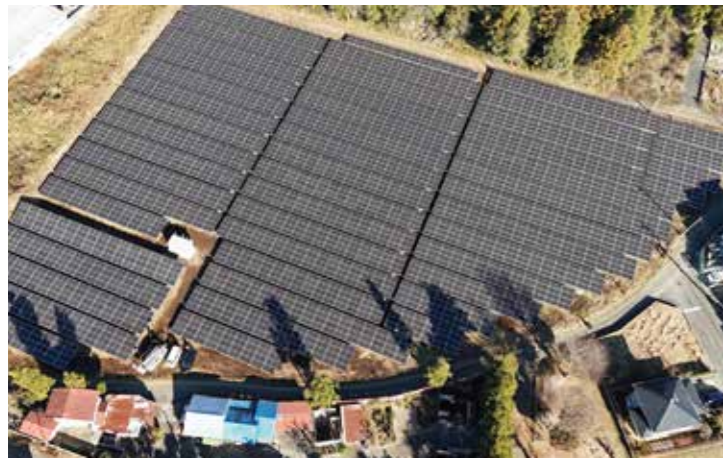
リープトン茨城町小幡発電所 1.59MW
